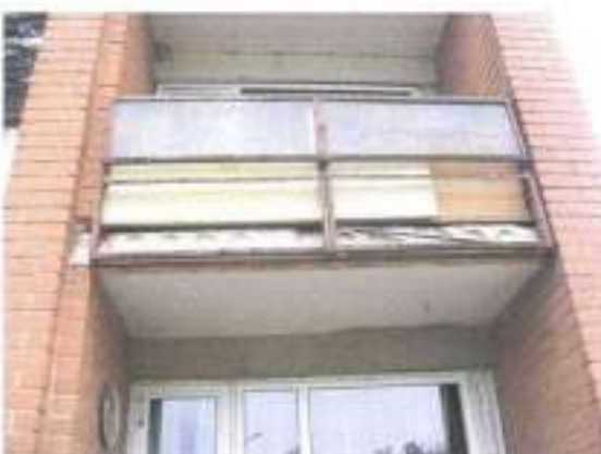
F-11, F-12. Lodžijās panelis ar brīvu malu. Virs augšējā stāva paneļiem gāzbetona izolācija no 10cm bieziem salauzītiem gabaliem.
