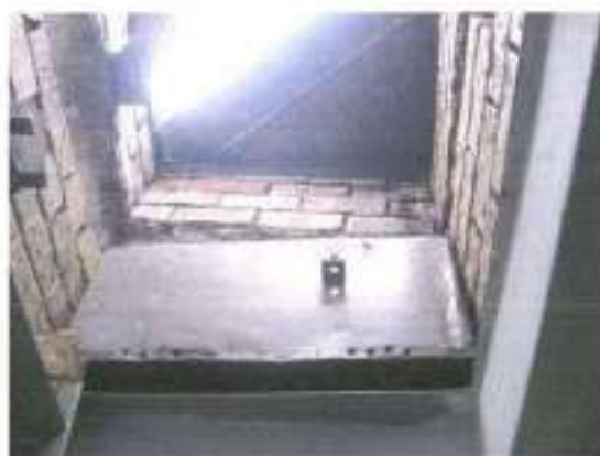
F-24, F-25. Jumta lūkas izveidotas caur augšas stāva un jumta pārsegumiem. Tās norobežotas ar ķieģeļu mūri 12cm.
