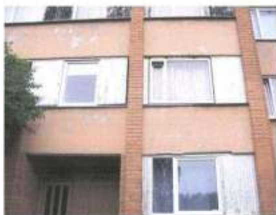
F-9, F-10. Sienu paneļa un mūra savienojuma šuvē tukša, tās platums atšķirīgs (0-2cm). Vāji un neprecīzi aizpildītas šuves starp sienas paneli un loga bloku vai koka starpliku.
