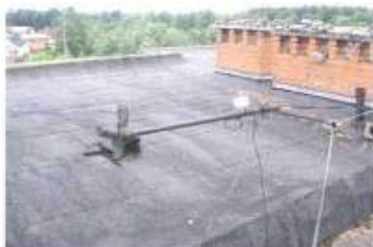
F-15, F-16. Kabeļu balsta caurule pārslodzes dēļ nogāzusies. Detaļa virs atkritumu vada; skārda malu noseģas ar daļēju uzkausējumu. Viļņainas jumta plaknes.
