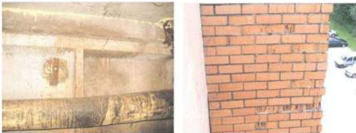
F-6, F-7. Cokola panelis (ribots, plakne 5cm biezumā) pagraba līmenī ar aizbūvētu atveri ventilācijai. Apdares māla ķieģeļu mūris augšdaļā izdrūp.
