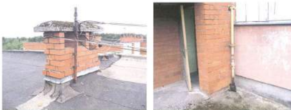
F-28, F-29. Kabeļi apgrūtina atjaunošanas iespējas šahtu izvadiem. Gāzes ievada vieta ēkā (katrā sekcijā) blakus ieejas durvīm pagalma pusē.
