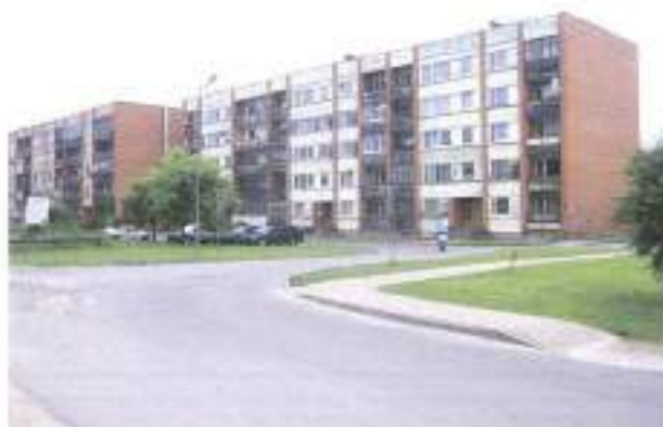
F-2. Asfaltētas piebrauktuves un autostāvvietā galvenās fasādes pusē, piebrauktuve no Nākotnes ielas. Ietve gar ielu un pie ēkas, segumi atdalīti.
