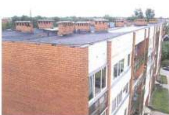
F-26, F-27. Šahtu gali virs jumta, masīvas betona plāksnes to nobeigumā, kanāls atvērts uz sāniem. Paši kanāli nestrādā pilnā mērā, tie vietām aizbīruši, nepieciešams iztīrīt.
