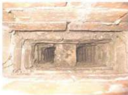
F-26, F-27. Šahtu gali virs jumta, masīvas betona plāksnes to nobeigumā, kanāls atvērts uz sāniem. Paši kanāli nestrādā pilnā mērā, tie vietām aizbīruši, nepieciešams iztīrīt.
