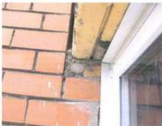
F-9, F-10. Sienu paneļa un mūra savienojuma šuvē tukša, tās platums atšķirīgs (0-2cm). Vāji un neprecīzi aizpildītas šuves starp sienas paneli un loga bloku vai koka starpliku.
