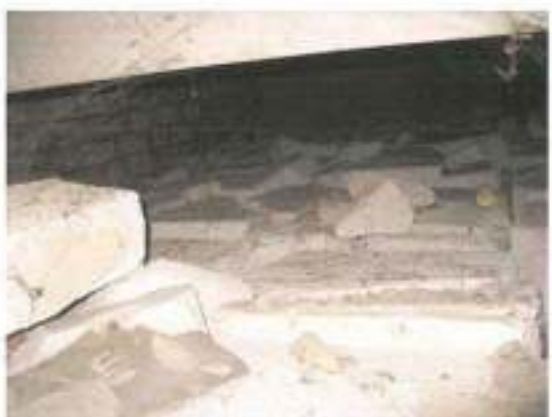
F-11, F-12. Lodžijās panelis ar brīvu malu. Virs augšējā stāva paneļiem gāzbetona izolācija no 10cm bieziem salauzītiem gabaliem.
