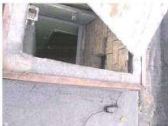
F-24, F-25. Jumta lūkas izveidotas caur augšas stāva un jumta pārsegumiem. Tās norobežotas ar ķieģeļu mūri 12cm.
