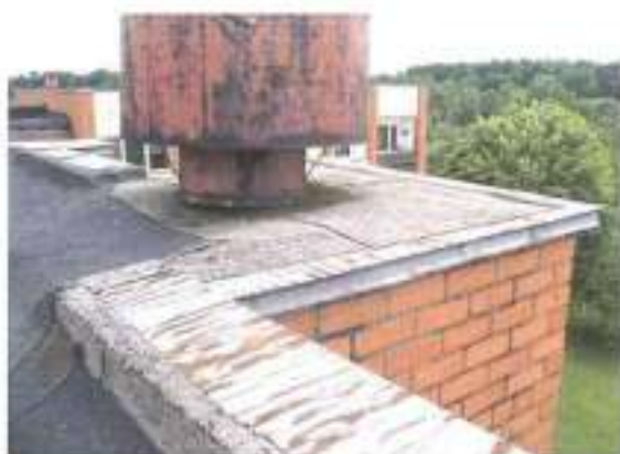
F-15, F-16. Kabeļu balsta caurule pārslodzes dēļ nogāzusies. Detaļa virs atkritumu vada; skārda malu noseģas ar daļēju uzkausējumu. Viļņainas jumta plaknes.
